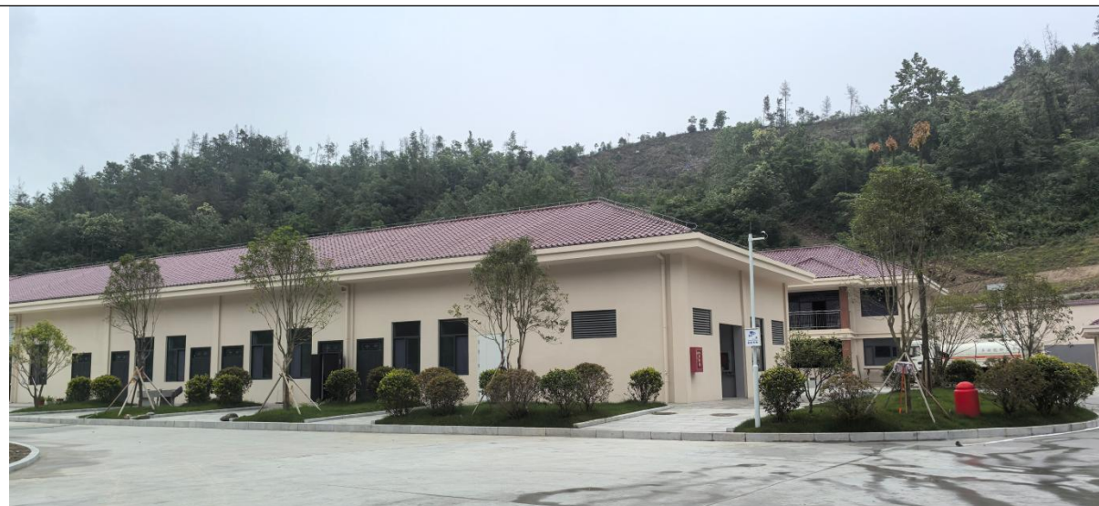
监控设施、厂区绿化
