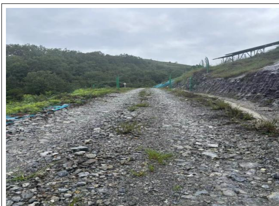
场区道路硬化
