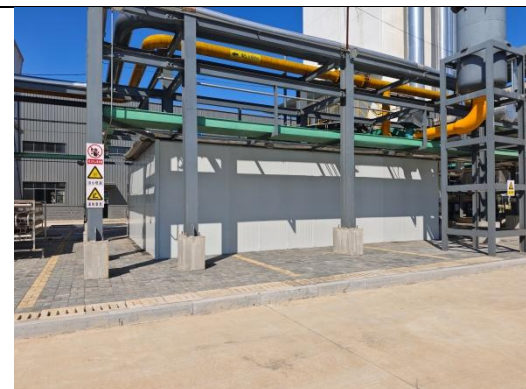
图 3-4 项目高噪声设备封闭厂房隔声
