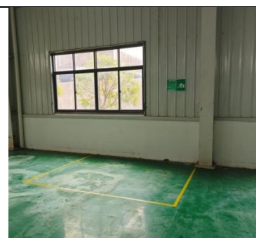
图 3-8 一般工业固废暂存间
