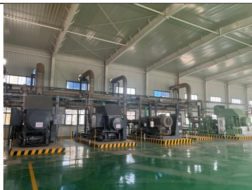
图 3-5 项目压缩机减振
