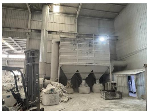
图 3-3. 破碎粉尘净化设施
