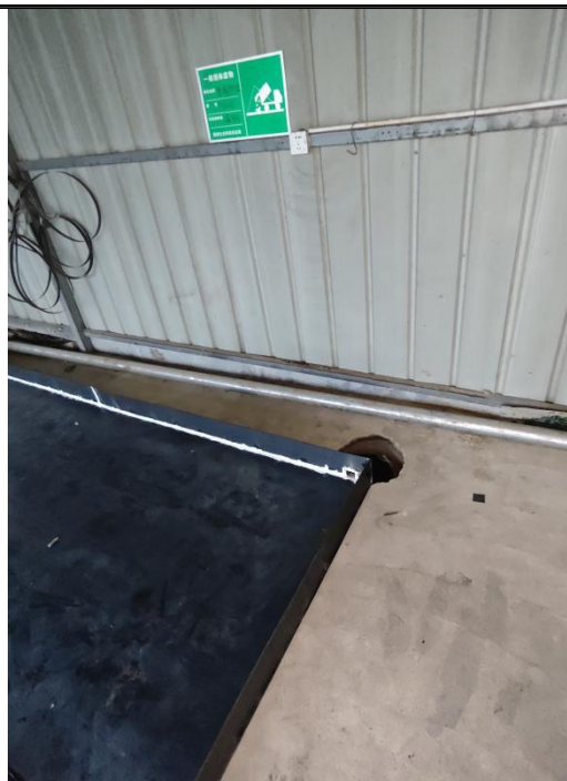
图 3-6. 防渗托盘及收集槽
